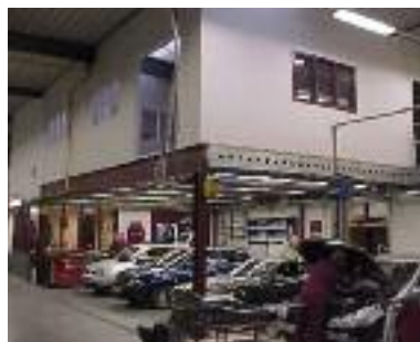
Verdiepingsvloer met overspanning van 14 meter
